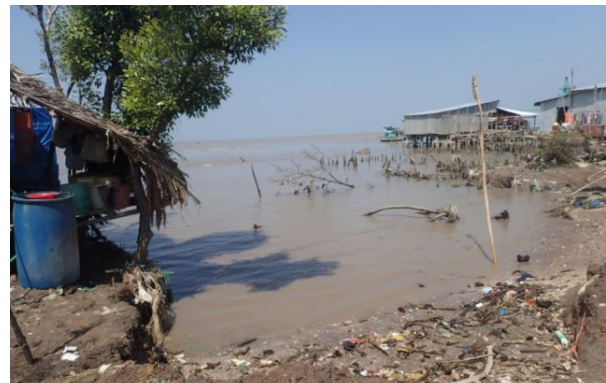
Durch Küstenerosion gefährdete Bebauungen im Mekong-Delta.
