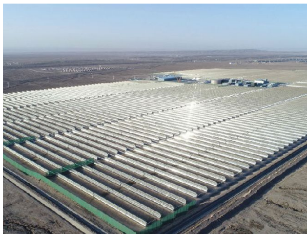
Erstes kommerzielles CSP Kraftwerk in China.
