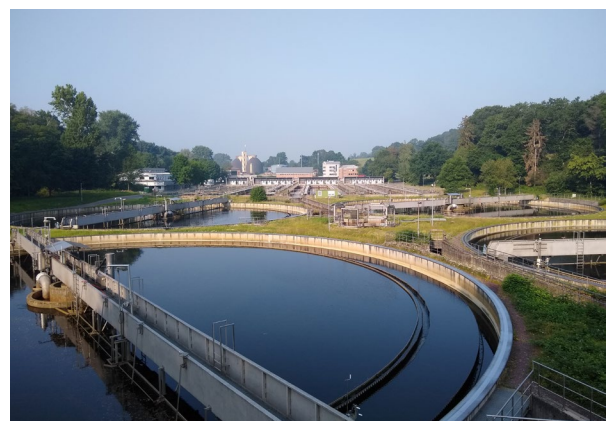
Kläranlage in Aachen-Soers.
