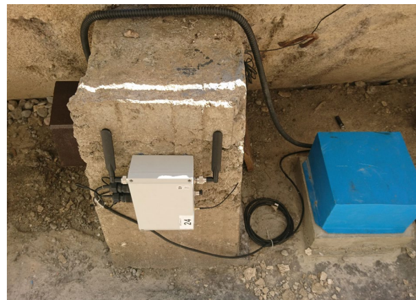
Installation seismischer Sensoren und des Echtzeitdatenübertragungssystems mittels WLAN-Technologie.
