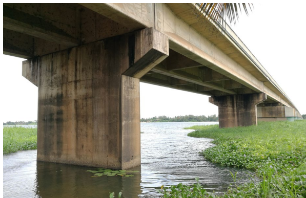
Verkehrsinfrastrukturen wie die Lower Volta Bridge sind Lebensadern in Ghana.
