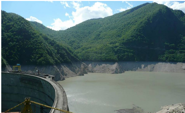
Der Enguri-Lake hat, verglichen mit anderen Staudämmen eine sehr hohe jährliche Wasserspiegelschwankung von ca. 100 m.
