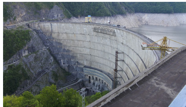
Die 277 Meter hohe Bogenstaumauer des Enguri-Staudamms in Georgien.
