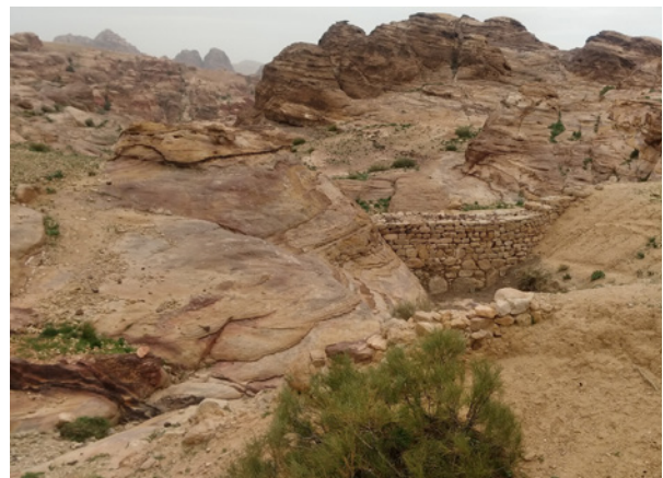
Wiederhergestellte historische Dämme im Wadi Musa in Petra, Jordanien.
