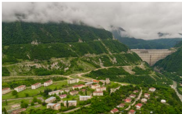
Die 277 Meter hohe Bogenstaumauer des Enguri-Damms in Georgien.
