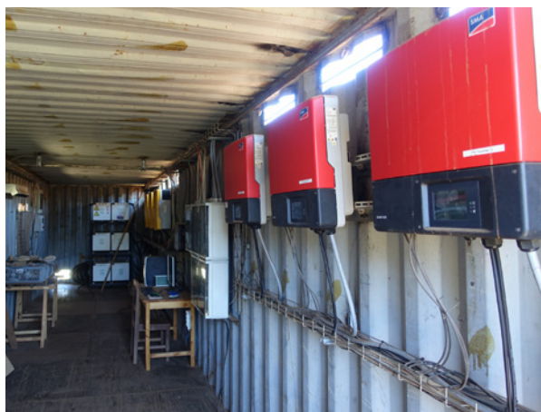
Das A:RT-D Grids-Team vernetzt Stromversorgung.
