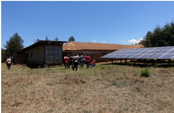
Stromversorgung mit Solaranlagen.
