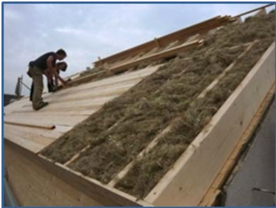
Утепление крыши ленточным волокном
