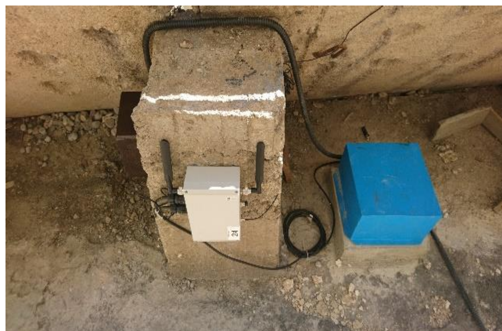
Installation seismischer Sensoren und des Echtzeitdatenübertragungssystems mittels WLAN-Technologie.
