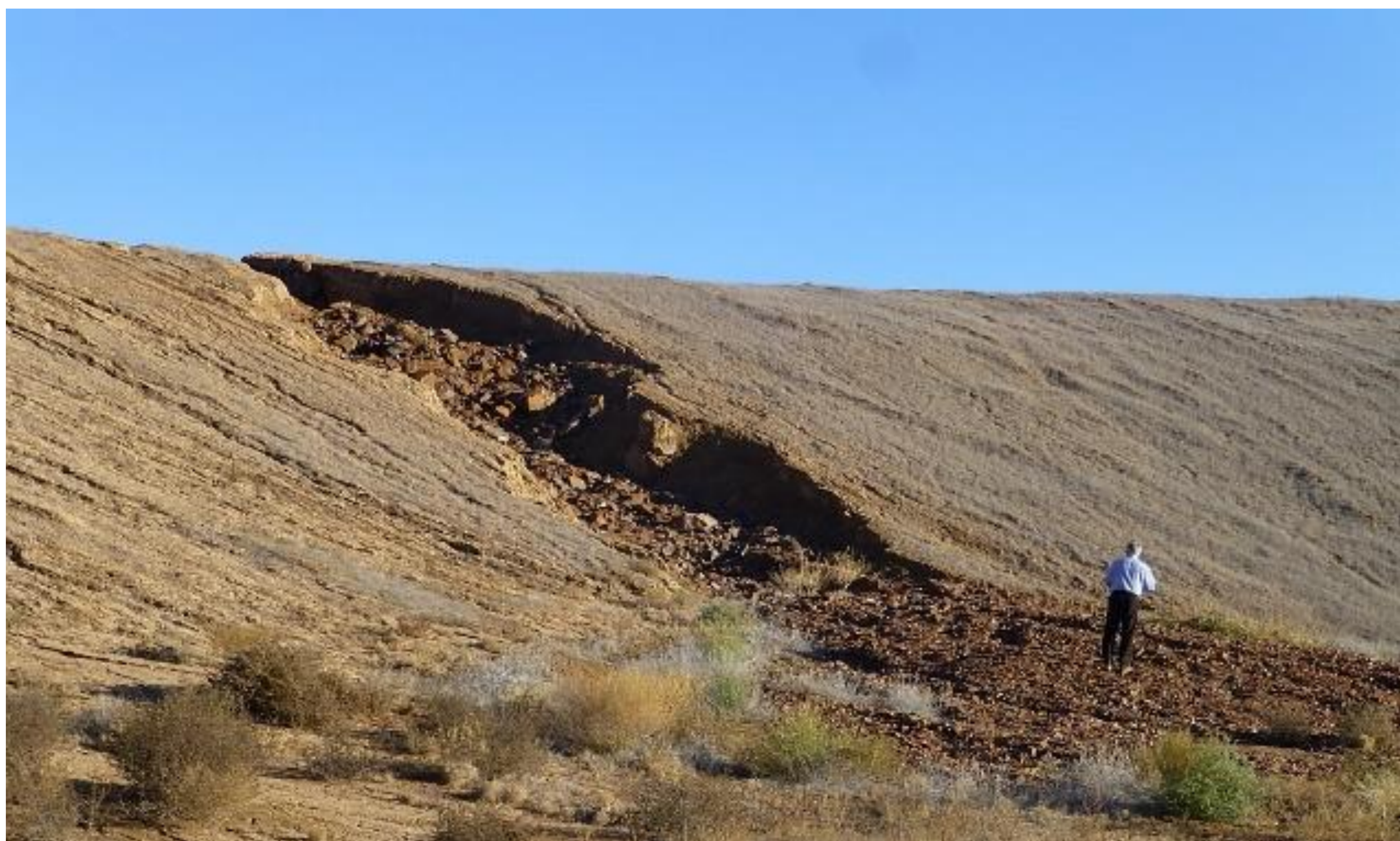
Bild 1: Erosionsrinne auf einer Uranbergbauhalde in Südkasachstan (Quelle: BGR)
